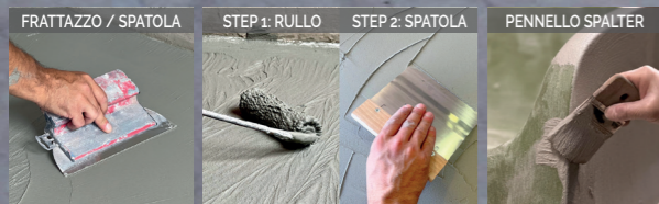
FRATTAZZO / SPATOLA STEP 1: RULLO STEP 2: SPATOLA PENNELLO SPALTER
